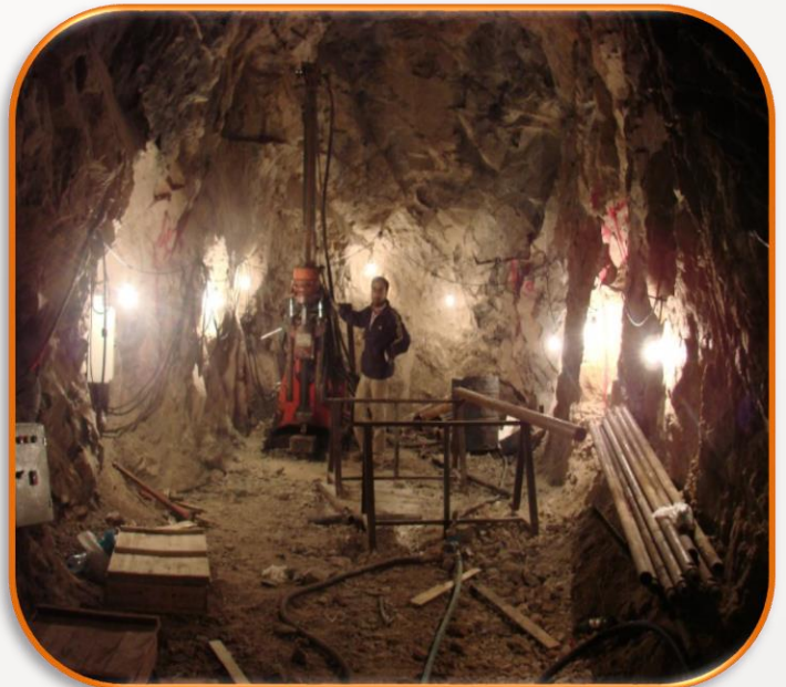
حفاری در داخل تونل
