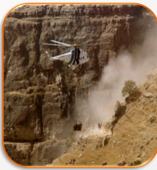
جابجایی تجهیزات حفاری با چرخبال
