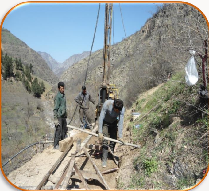
حفاری در بدنه سد
