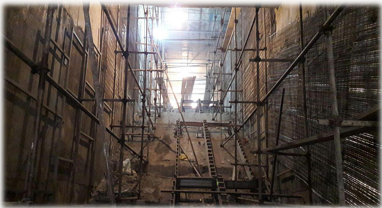
احداث ایستگاه M3 متروی خط ۳ تهران و تونل‌های جانبی
